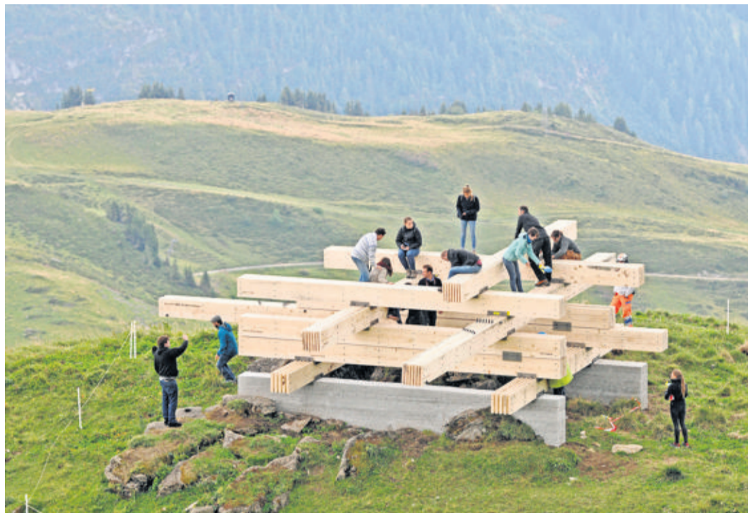
Préfabriquée aux Aviolats, l'œuvre a été installée en deux heures par un hélicoptère à Isenau.
